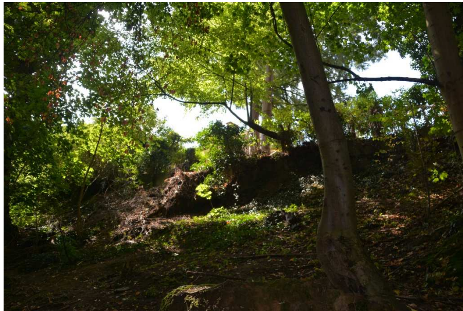
IA11_08 Des déchets de jardins et des petites quantités de terre ont été déversés sur le haut du talus, et les enlever complètement semble difficile. Une sensibilisation des habitants et des gestionnaires des espaces verts est nécessaire pour faire cesser ce comportement. (photo 2017)
